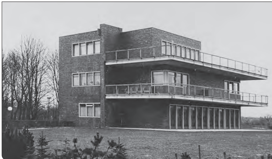
Archiv Müller-Drenkberg: Das Haus Müller-Drenkberg kurz nach der Fertigstellung in den 1930er Jahren
