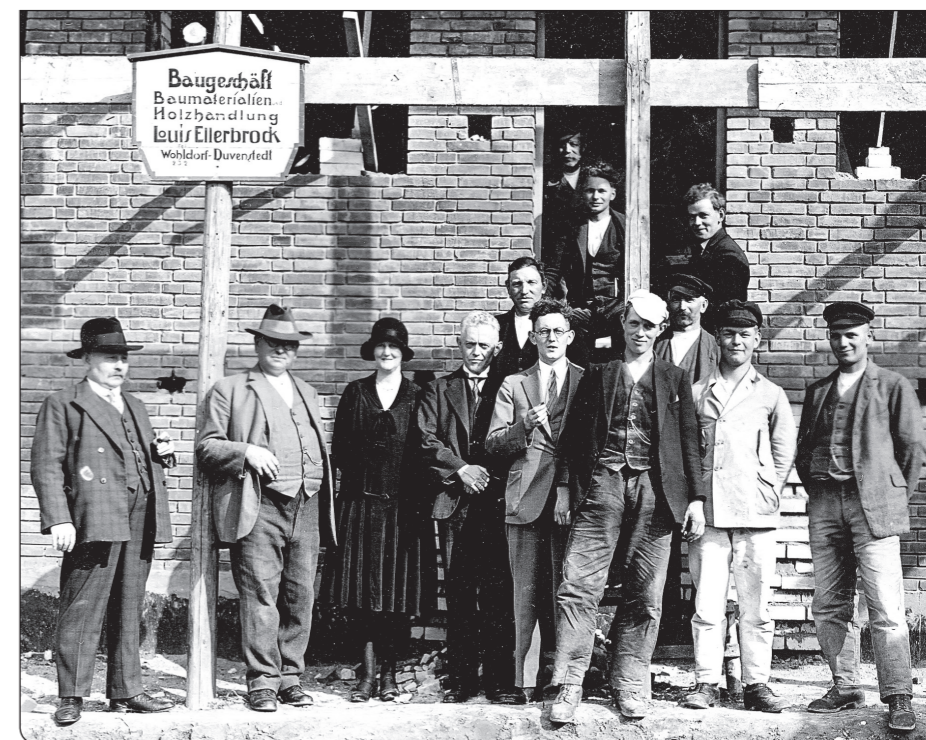
Der Rohbau des Hauses Alsterhöhe 3 ist fertig (1930)
