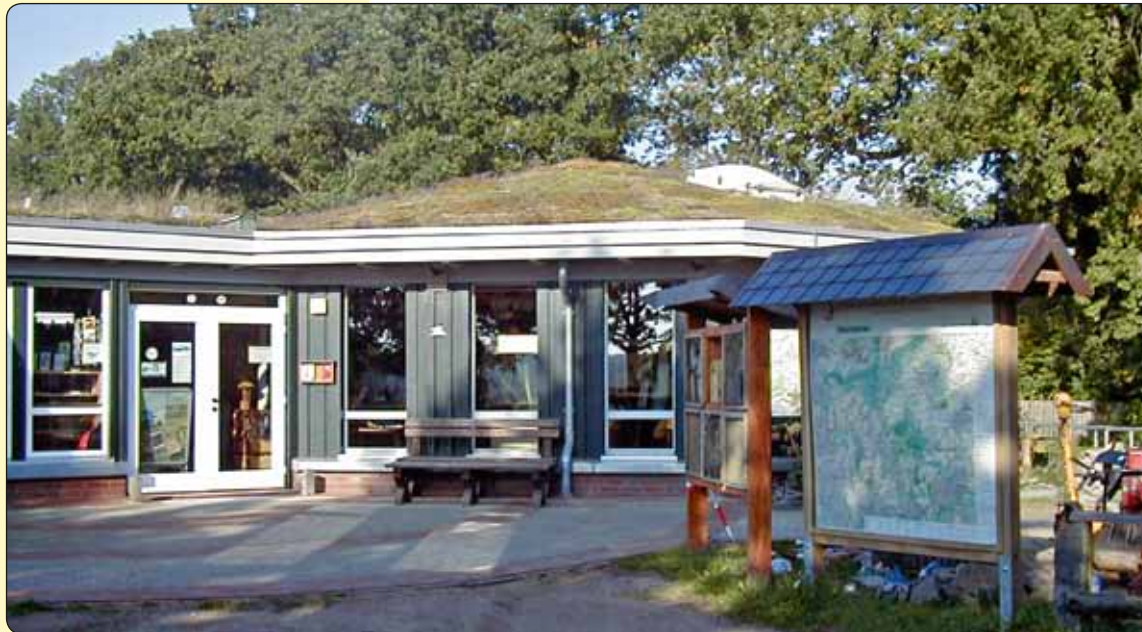
Am Duvenstedter Triftweg wird eines neues Informationshaus errichtet
